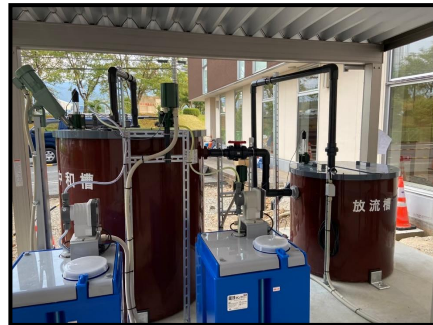
株式会社エイチツー 納入事例 | 自動pH中和装置 | 透析排水の中和処理より画像引用
